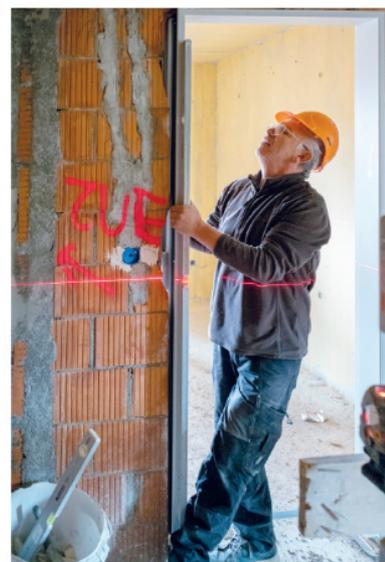
Eine Wasserwaage hilft beim präzisen Ausrichten der Türen. Zum Schluss wird der Hohlraum zwischen dem Mauerwerk und der Stahlzarge mit Mörtel ausgegossen, wodurch die Zarge fest mit dem Gebäude verbunden wird.
