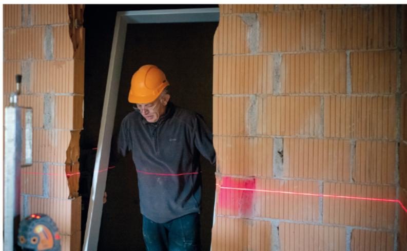
Rückzuck hat Stahlzargenmonteur Cosimo La Torre die Türzarge aufgerichtet und in die Türöffnung eingepasst. Bilder: PB
